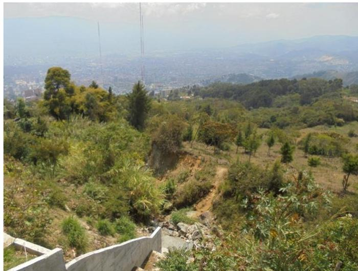
**FOTOGRAFÍA 113. ESTACIÓN CL 077 E: 831.347 N: 1.188.416, QUEBRADA CORCOVADA, OBSERVESE SOCAVACION AL FINALIZAR EL DISIPADOR DE ENERGIA**
