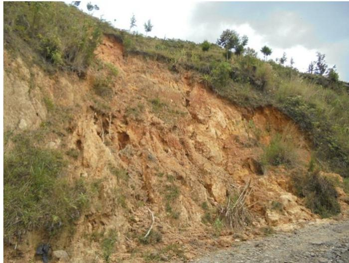
**FOTOGRAFÍA 100. DESLIZAMIENTO ROTACIONAL GENERADO POR PERDIDA DE SOPORTE EN EL TALUD ESTACIÓN CL 040 E: 824.382 N: 1.181.829 CARRETERA SAN ANTONIO DEL PRADO VEREDAD EL SALADO**
