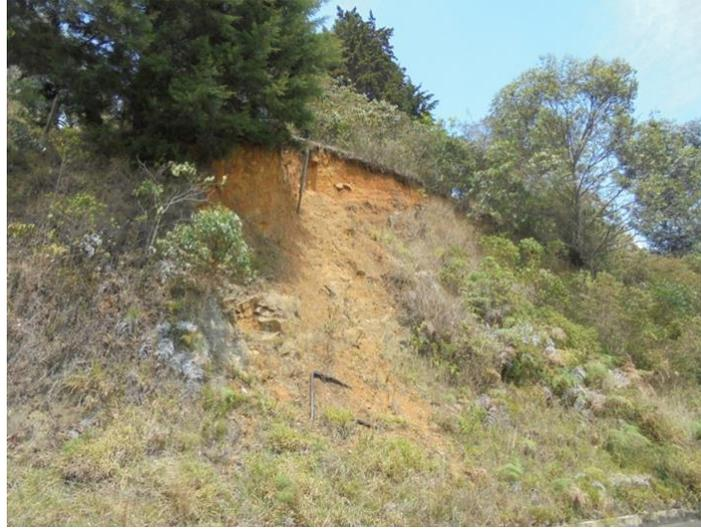
**FOTOGRAFÍA 103. DESLIZAMIENTO GENERADO EN EL CORTE DE LA CARRETERA ESTACIÓN CL077 E: 831.347 N: 1.188.416 VIA MEDELLIN AL MAR VEREDA LA ILUSIÓN**
