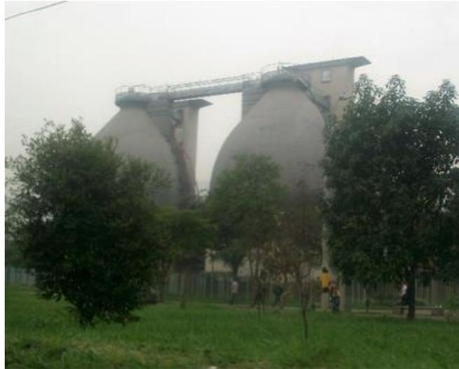
**FOTOGRAFÍA 78. DOMOS PARA TRATAMIENTO ANAEROBIO DE LODOS EN EL STAR SAN FERNANDO**
